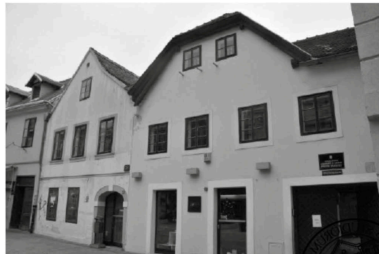
zgrada Pravne klinike
